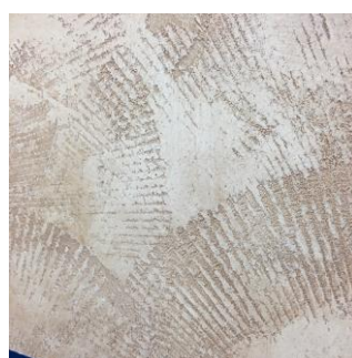
キャタピラー型ローラーで特徴的なスクラッチもできます。
