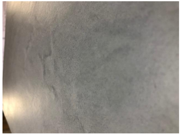
2 度目塗り付け+押え磨き
